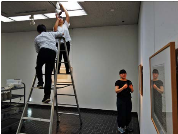
写真25 照明を取りつけている様子
